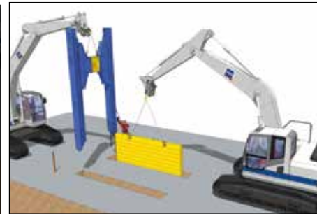
Mise en place du portique sur le 1 er panneau (maintenu par engin).
