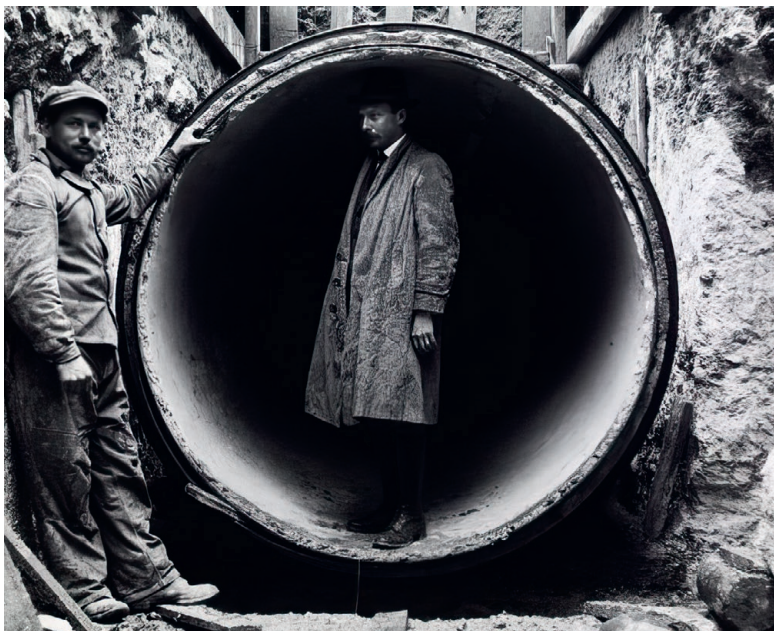
Aqueduc du Loing, doublement des siphons de la Bièvre
